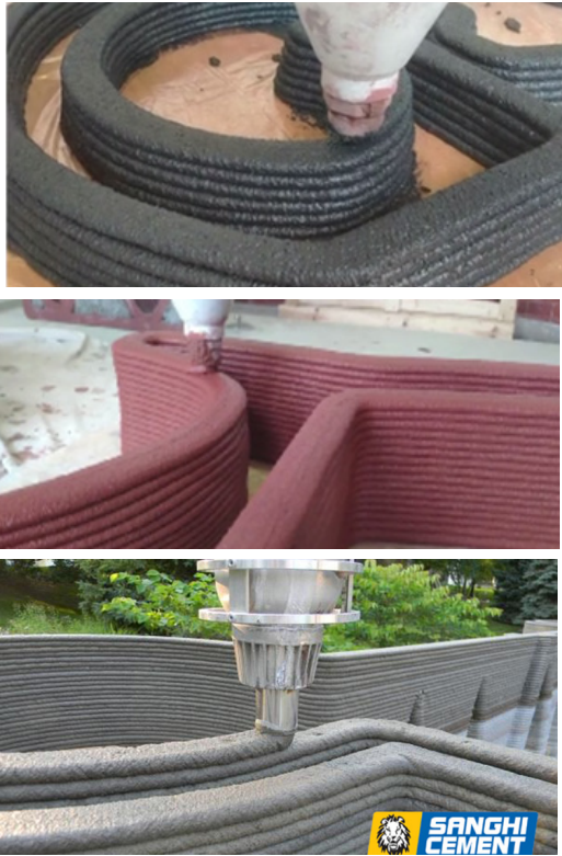
Hình 1. Công nghệ in 3D sử dụng bê tông hạt mịn geopolyme
